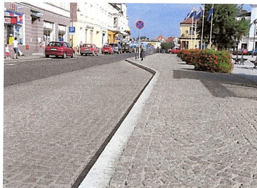
ZDJĘCIE: ZATOKA AUTOBUSOWA WE WRZEŚNI
